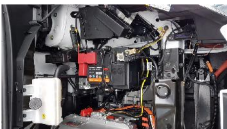
Système de batterie et moteur électrique
