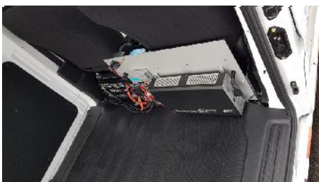
Inverter et Lilon Batterie
