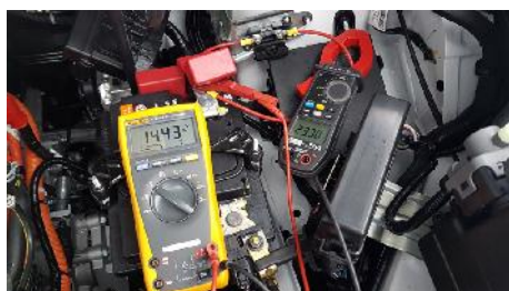
DBM Ladestrom (23A) und Systembatterie Spannung 14.4V
